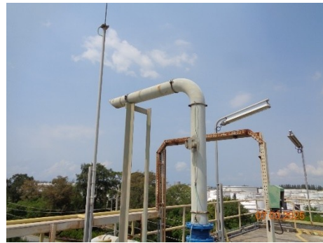
03K002 : Vent 03T001A/B (Holding Tank)
