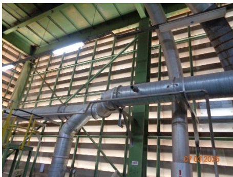
05F002/07F004 : Vent ระบบ Flash Dryer
