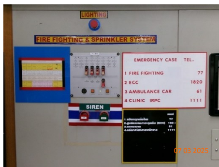
ภาพที่ 2.2-2 ระบบควบคุมอัตโนมัติในการเปิด/ปิดวาล์วนิรภัย
